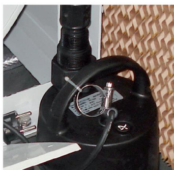
Vodní čerpadlo s hladinovým spínačem.
