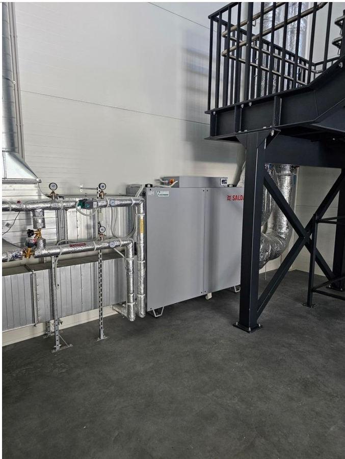
Jednotky CXP instalované na boku
