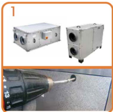
Odšroubujte panel s ventilátorem.
