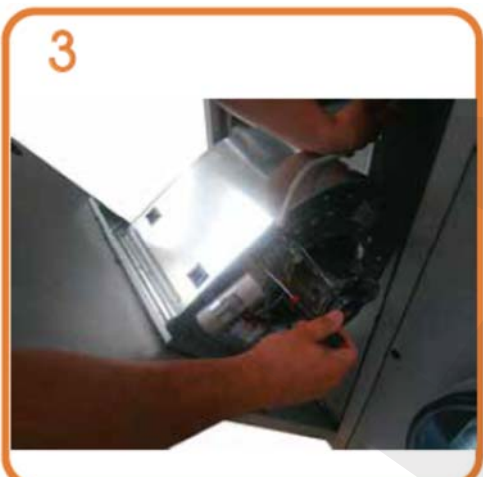
Odšroubujte a odstraňte čelní panel s ventilátorem.
